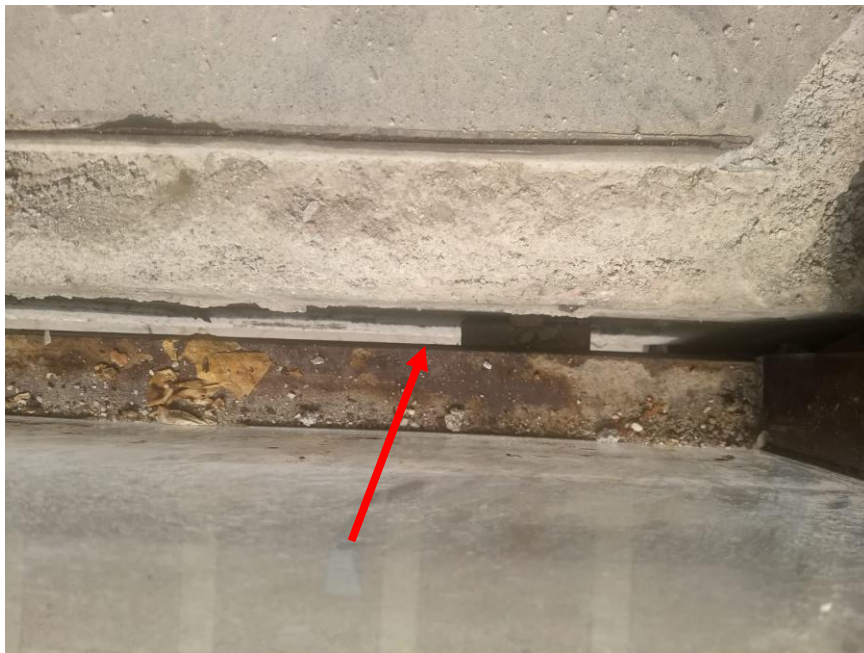
Img. 6.4 – Telaio secondario e fessura passante tra i piani
