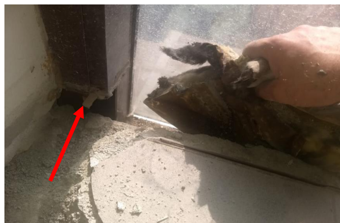
Img. 6.6 – Possibili forature nel telaio metallico individuato in precedenti sopralluoghi
